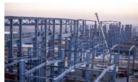
基础设施建设
